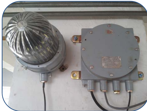
图3 本安型 IIC 防爆 AP 定位器
